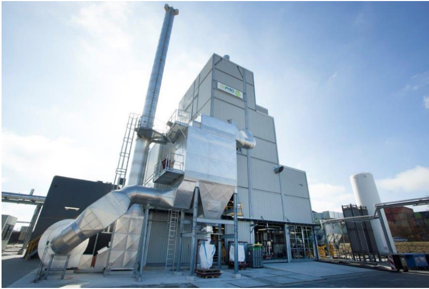
BTG (NL) : 125 t/d transported bed - Empyro
